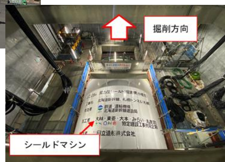
【発進立坑内の状況写真】
