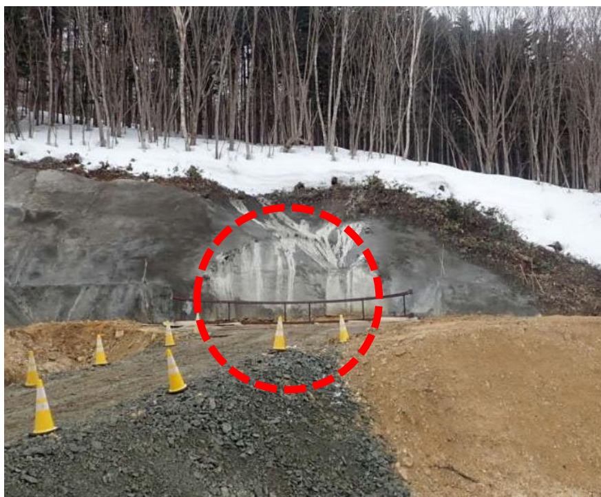
【掘削前の坑口の写真】
